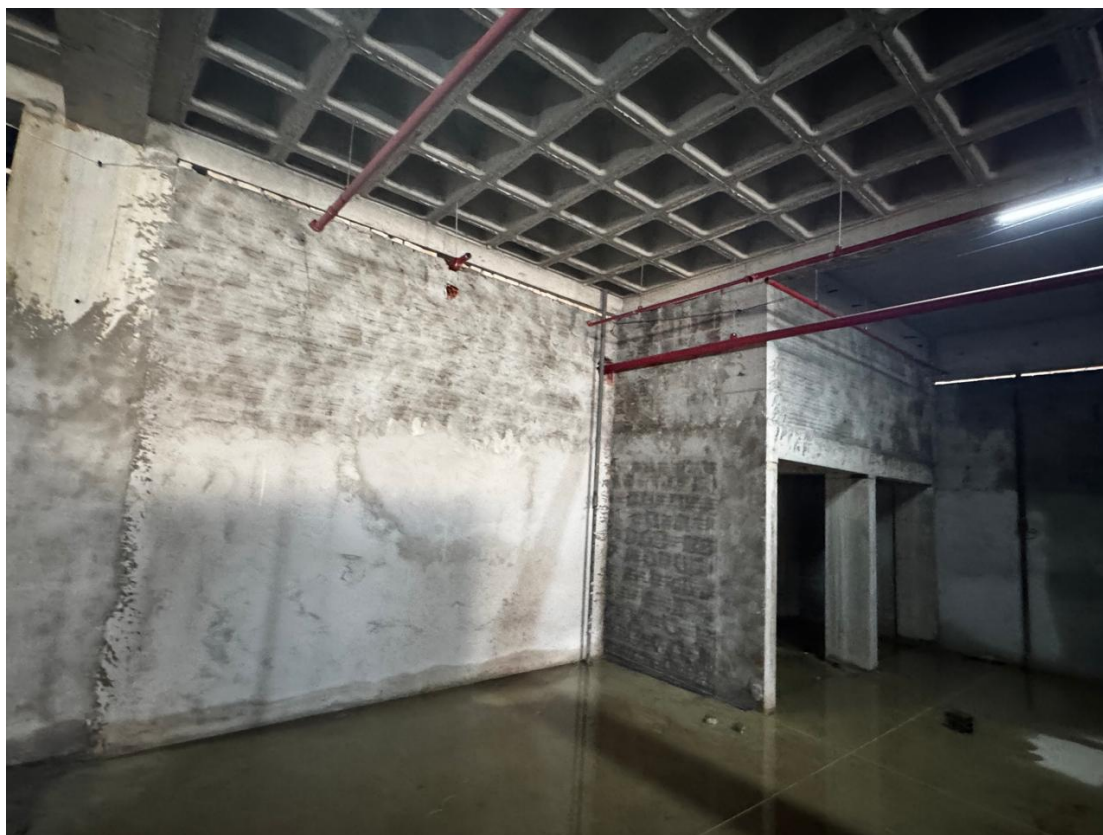
Figura 11. Chapisco e massa única aplicado nas paredes internas.
