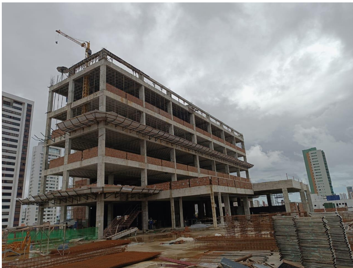
Figura 2. Instalação de bandeja secundária no perímetro do terceiro pavimento.
