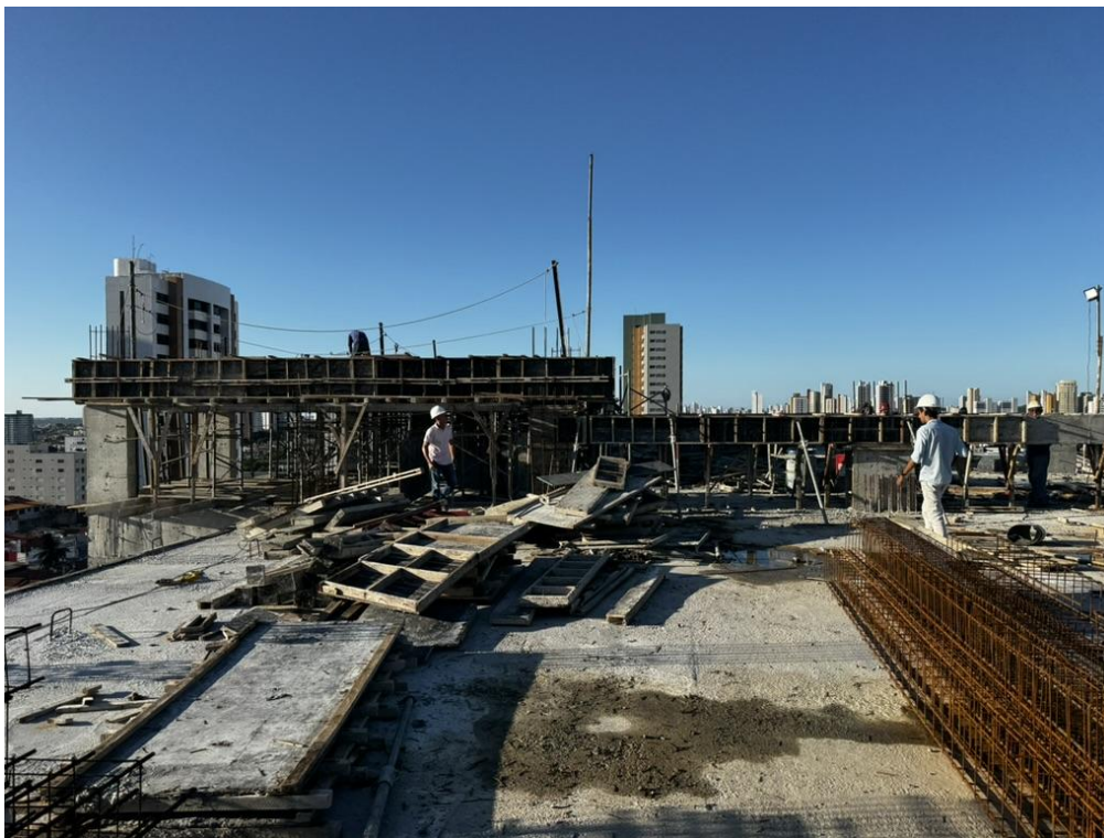
Figura 5. Concretagem da laje de cobertura do quarto pavimento.
