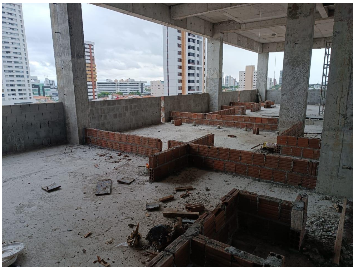
Figura 08. Execução de alvenaria de 9cm nas paredes dos banheiros no segundo pavimento
