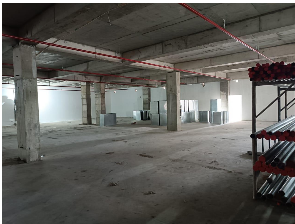
Figura 13. Instalação das tubulações de aço galvanizado de hidrantes e sprinkler.
