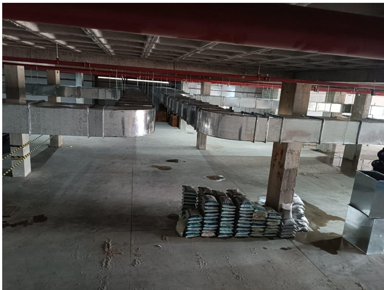
Figura 16. Instalação do sistema de exaustão com chapas galvanizadas
