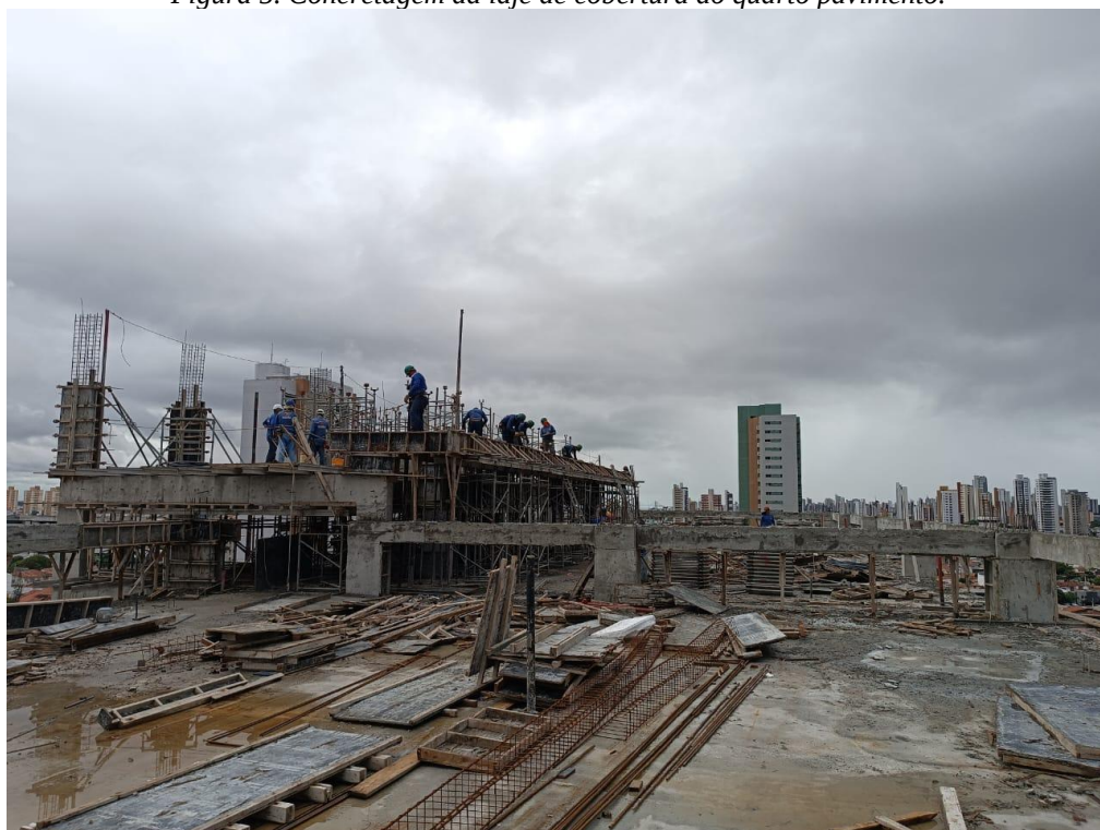
Figura 6. Concretagem da laje dos reservatórios e platibanda da cobertura.
