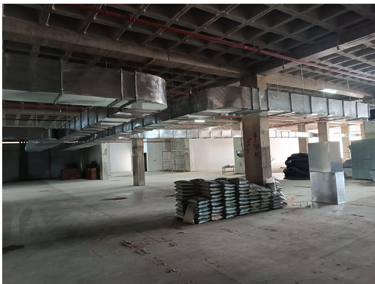
Figura 15. Instalação do sistema de exaustão com chapas galvanizadas
