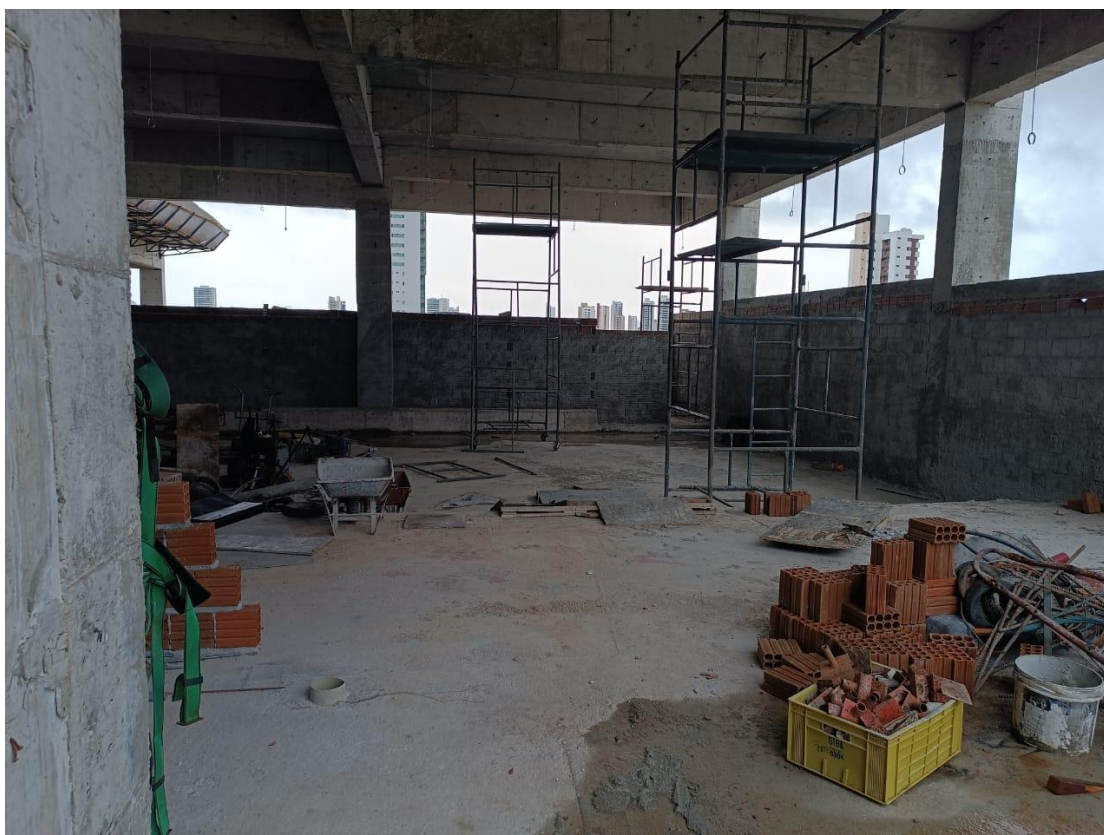
Figura4. Andaimes para elevação das alvenarias no pavimento térreo.
