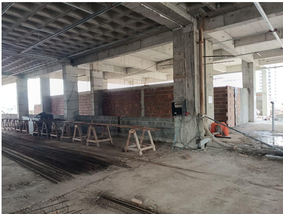
Figura 09. Execução de alvenaria 14cm no perímetro do auditório no pavimento térreo.
