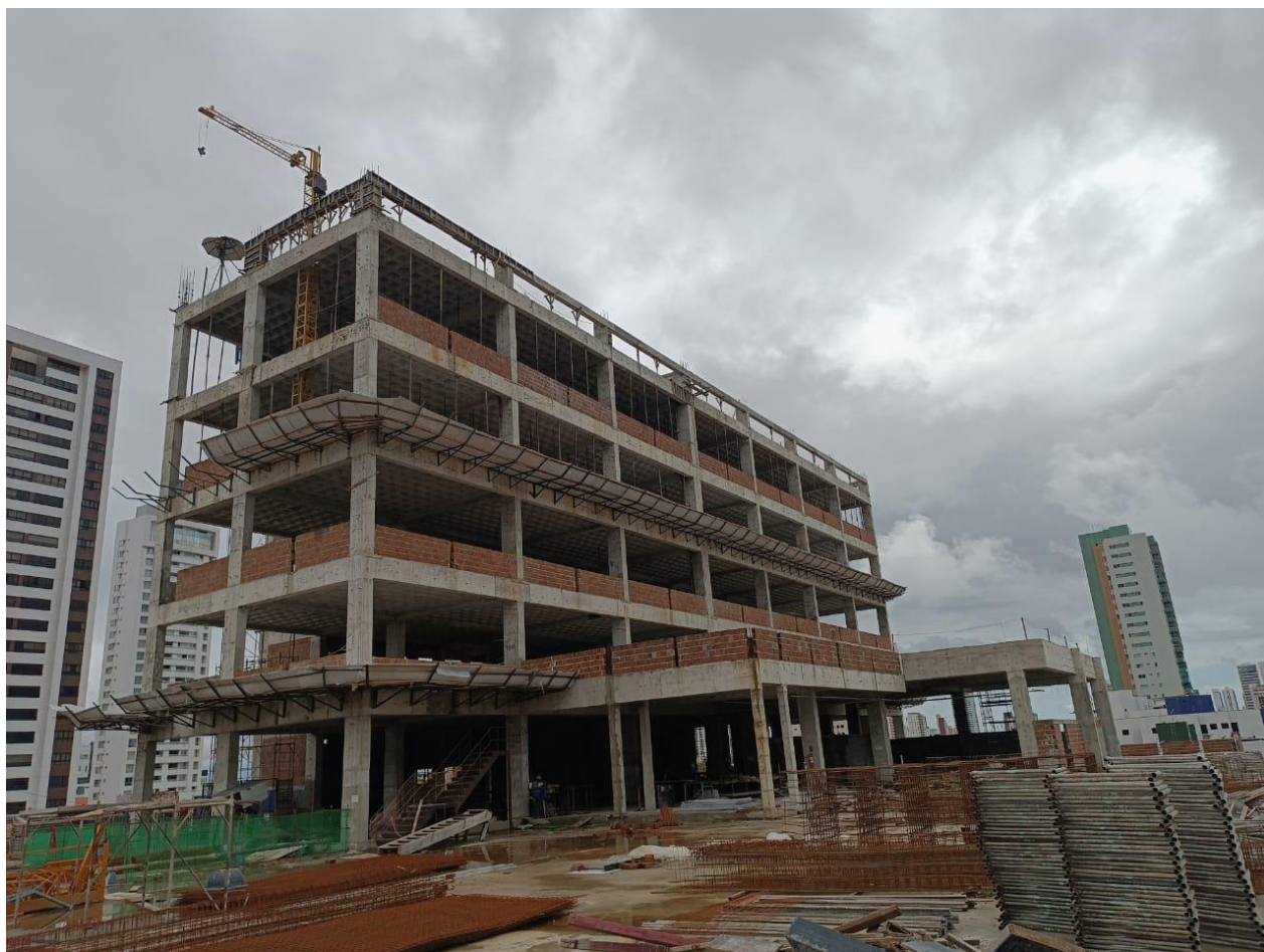
Figura 1. Visão geral da obra.
