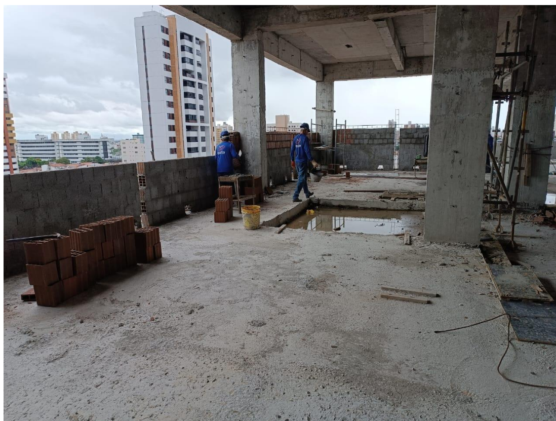
Figura 10. Execução de alvenaria com tijolos cerâmicos de 14cm de largura no perímetro dos pavimentos.
