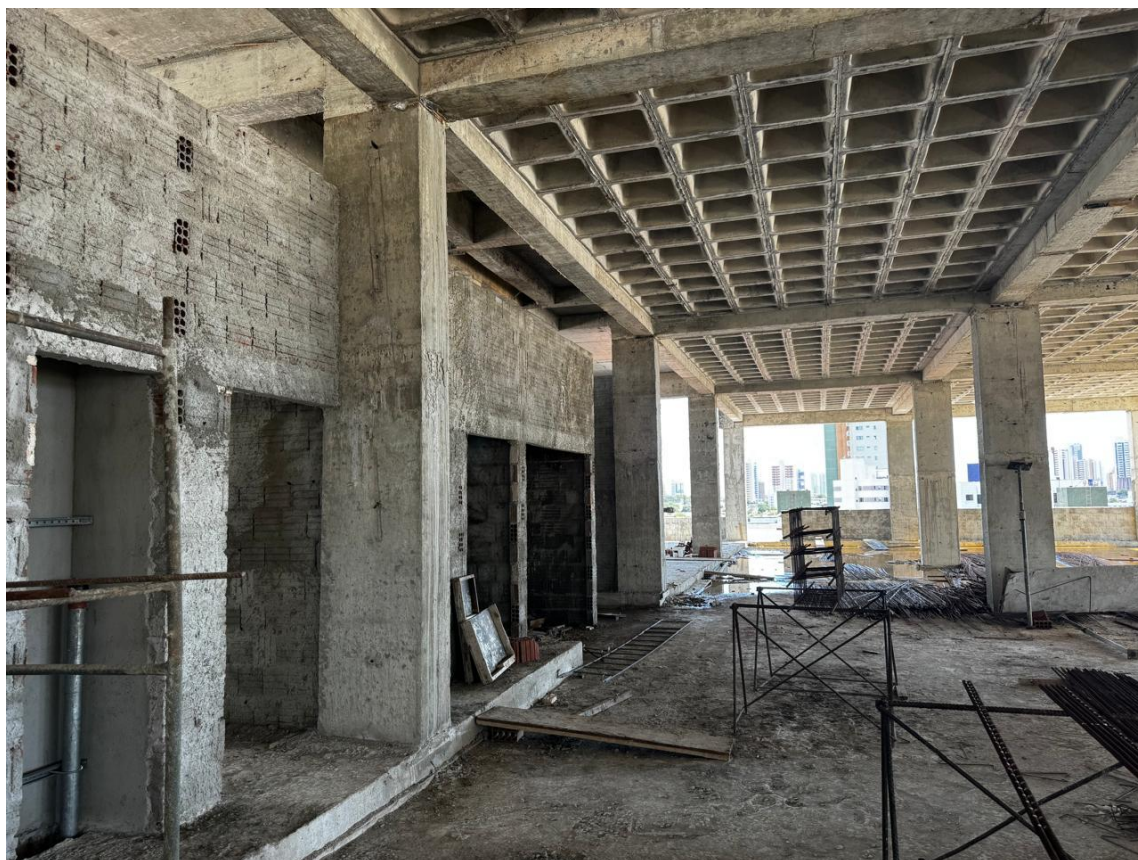
Figura 7. Execução de alvenarias com tijolos de 9cm de espessura nos banheiros do pavimento térreo.
